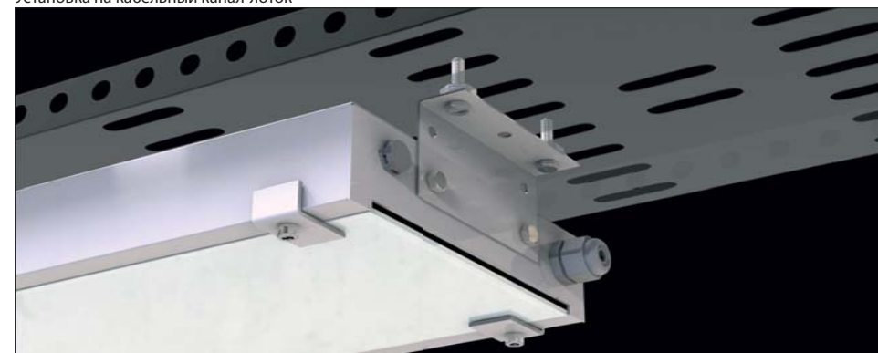
Установка на кабельный канал-лоток
